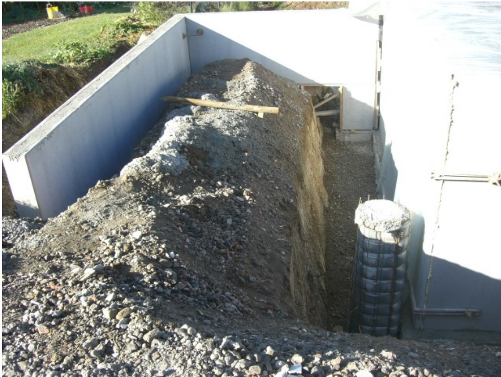
Abbildung 3.5: Fundamente für Garage setzen & Punktfundament giessen
