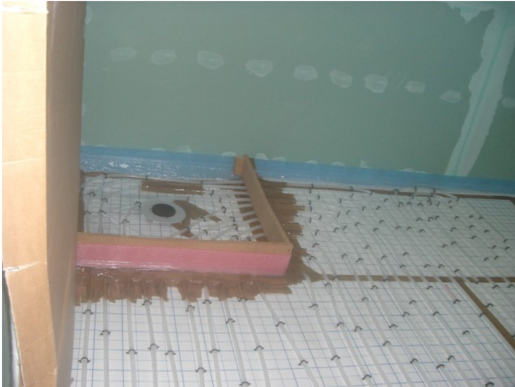
Abbildung 3.28: Doppelte Anzahl Fussbodenheizungsschlaufen im Bad; Abtrennung Duschbereich da dort anderer Estrich benötigt
