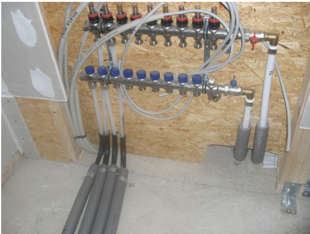
Abbildung 3.31: Montage Heizverteiler EG
