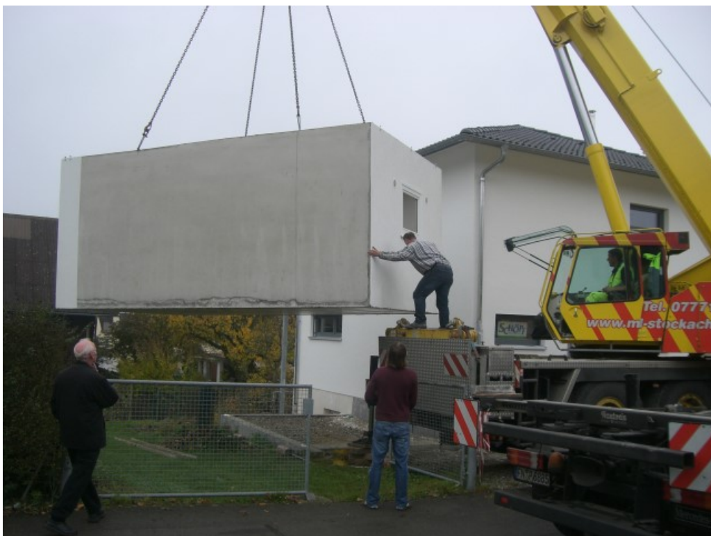
Abbildung 3.38: Setzen der Garage
