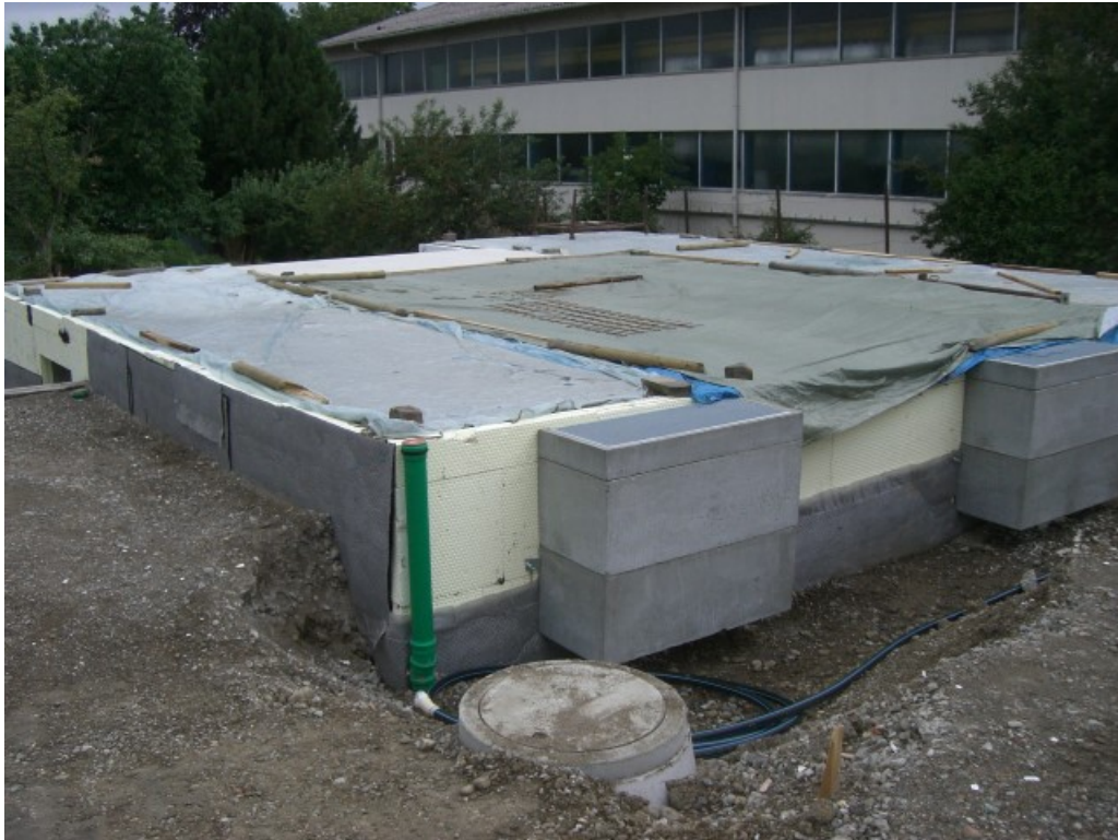
Abbildung 3.15: Abdeckung Kellerdeckenplatte und regelmässiges befeuchten
