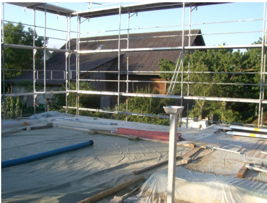
Abbildung 3.16: Stellen des Gerüsts
