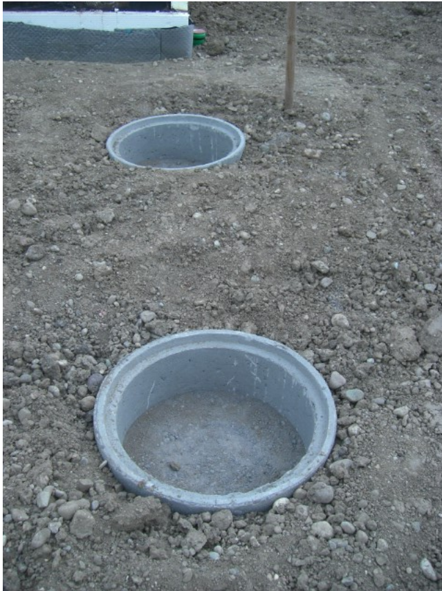
Abbildung 3.13: Setzen der Fundamente für Terrasse
