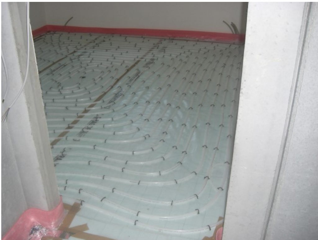
Abbildung 3.27: Bodendämmung und Fussbodenheizung
