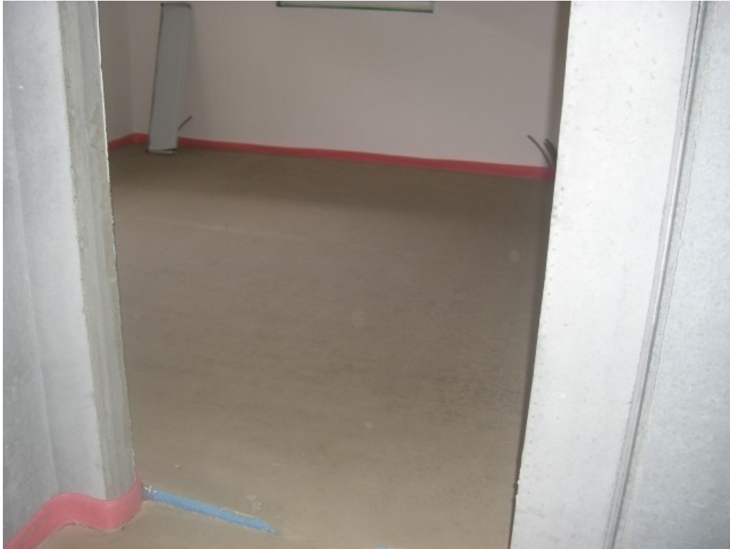
Abbildung 3.30: Estrichtrocknung
