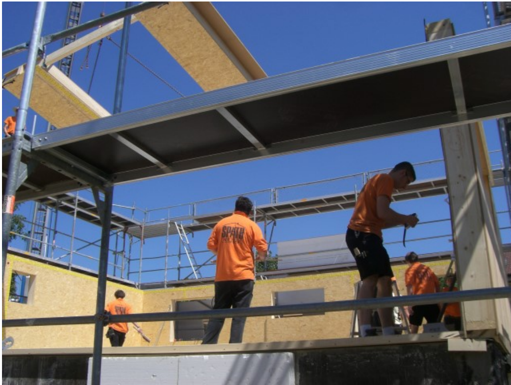
Abbildung 3.17: Montage der Hauswände
