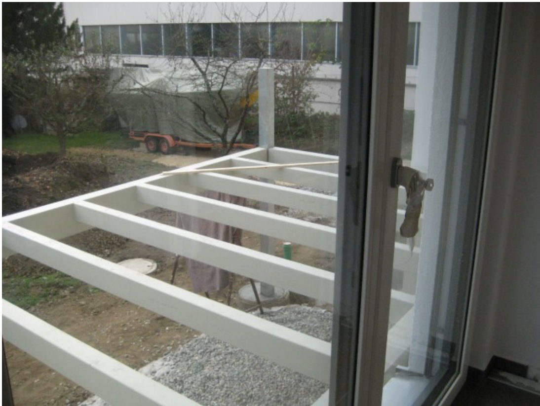
Abbildung 3.37: Aufbau der Hochterrasse
