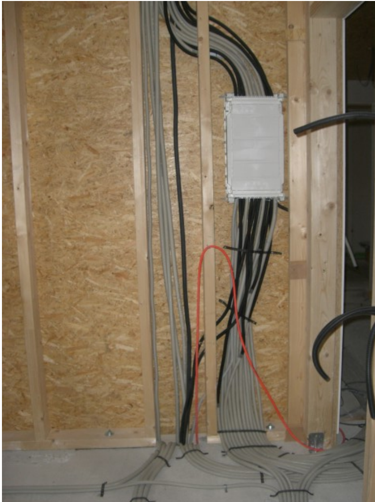
Abbildung 3.22: Einbau der Elektrik in Innenwände
