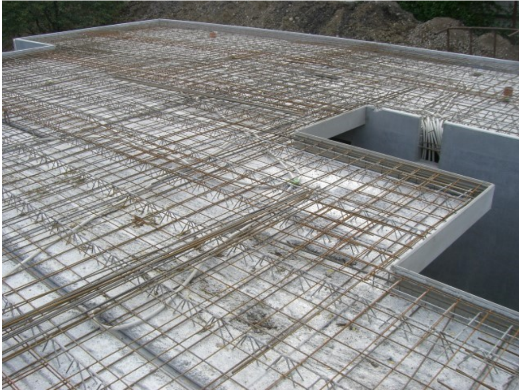
Abbildung 3.7: Stahlarmierung Kellerdecke
