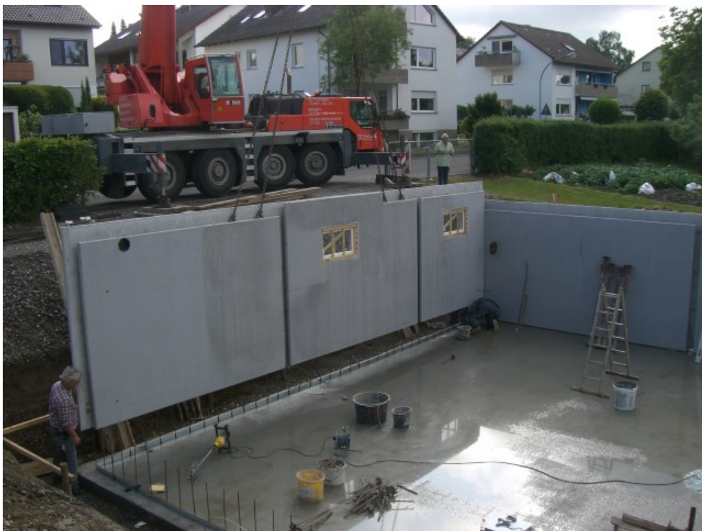
Abbildung 3.6: Keller Wände (Fertigteile) stellen
