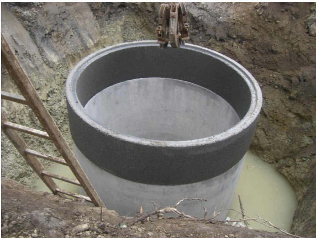
Abbildung 3.21: Setzen der Regenzisterne mit Versickerungsring
