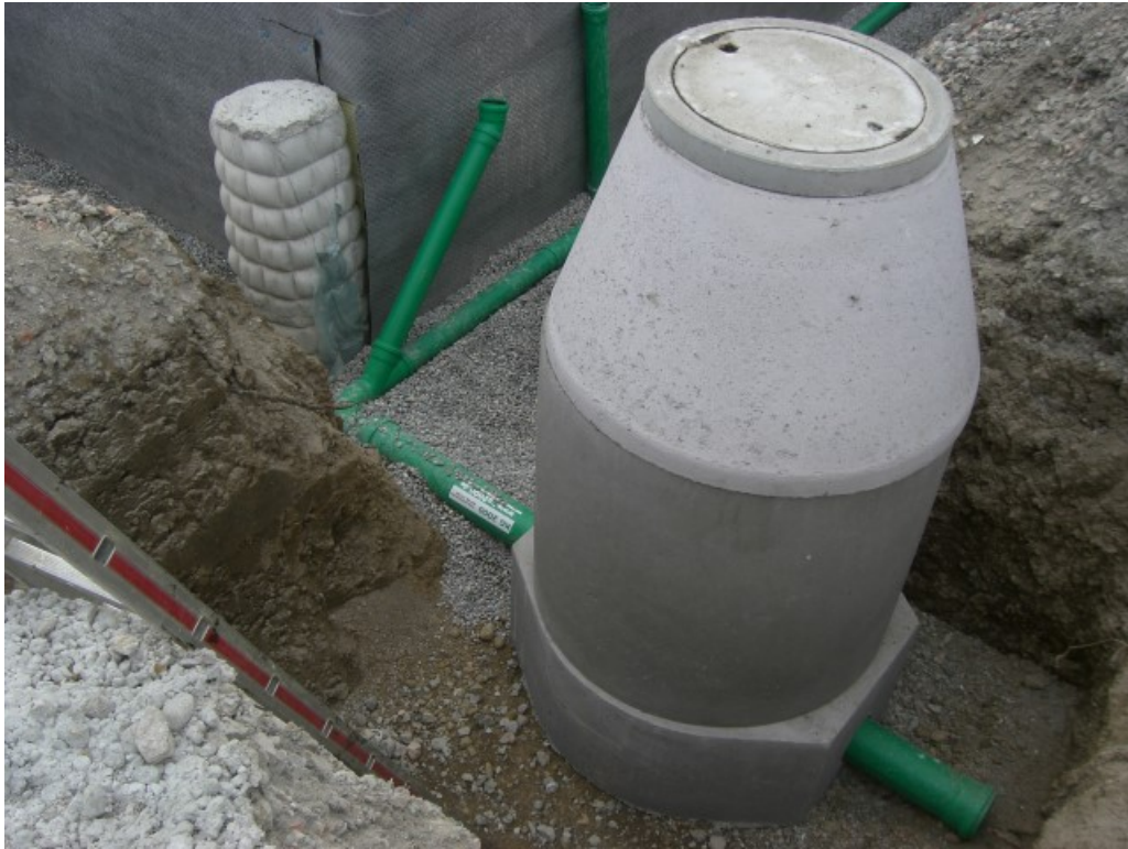
Abbildung 3.9: Kontrollschacht und Abwasserrohre anbringen
