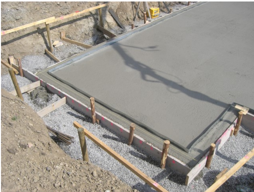
Abbildung 3.4: Keller Fundament gegossen
