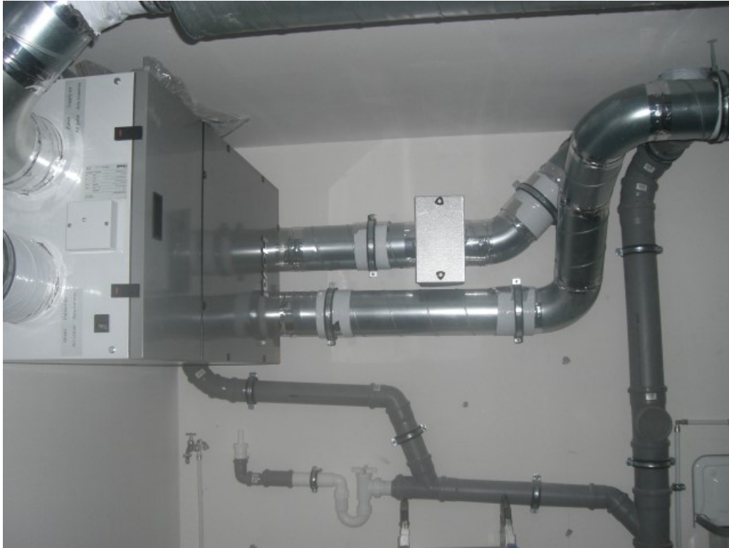
Abbildung 3.24: Einbau der Belüftungsanlage (Rohre ungedämmt)
