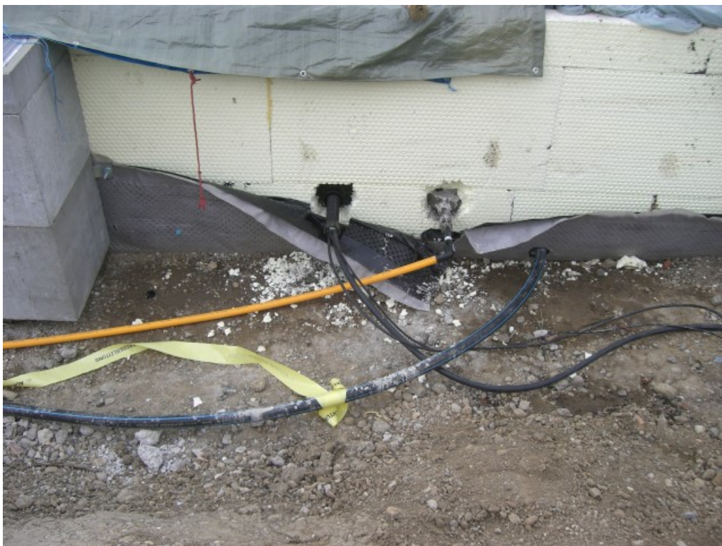
Abbildung 3.14: Anschluss der Wasser und Gasleitung (nocht nicht ausgeschäumt)
