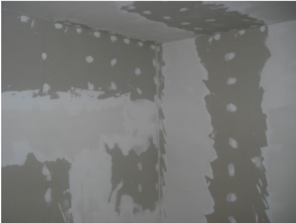
Abbildung 3.33: Verspachteln Regibsplatten
