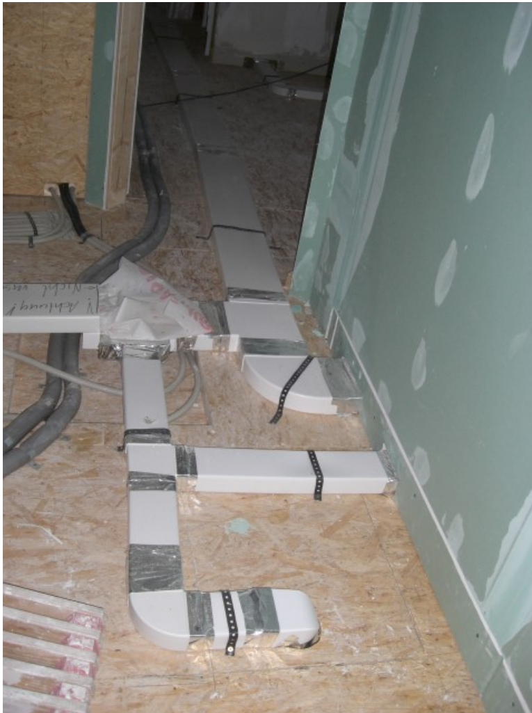
Abbildung 3.23: Einbau der Belüftungsrohre
