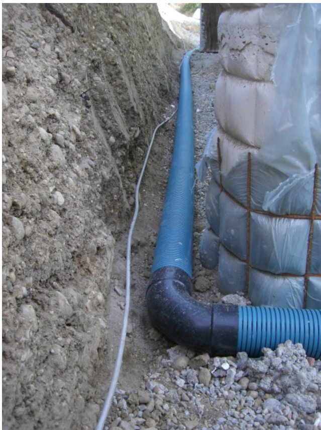
Abbildung 3.10: Ringdrainagen setzen
