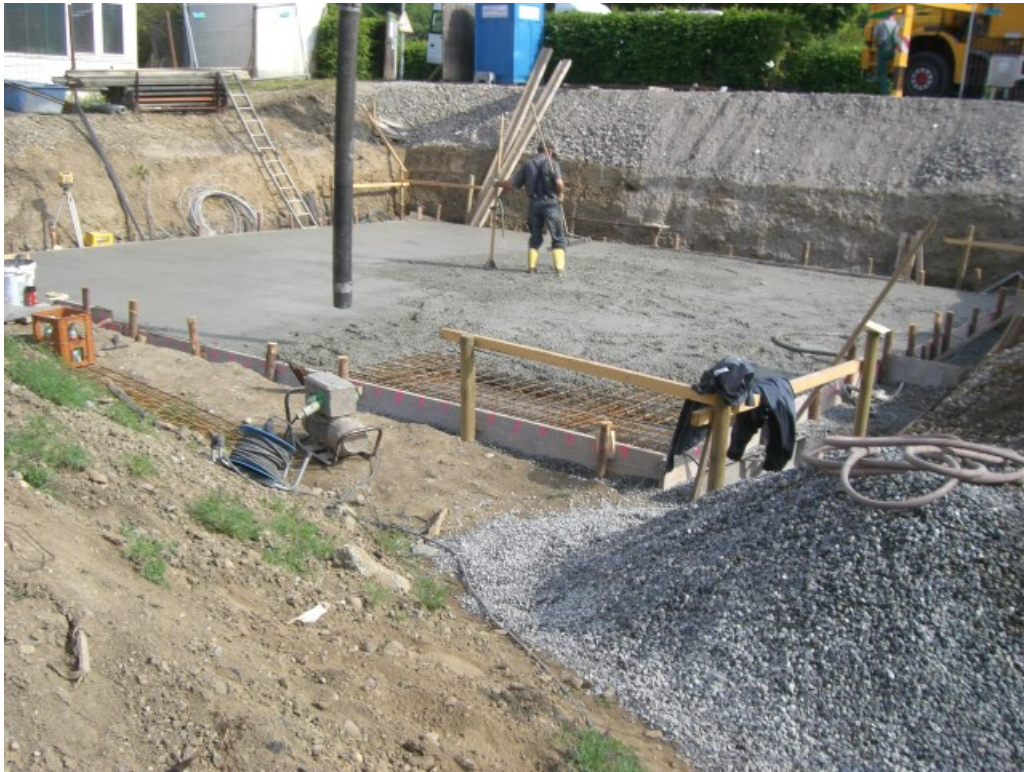
Abbildung 3.3: Keller Fundament giessen
