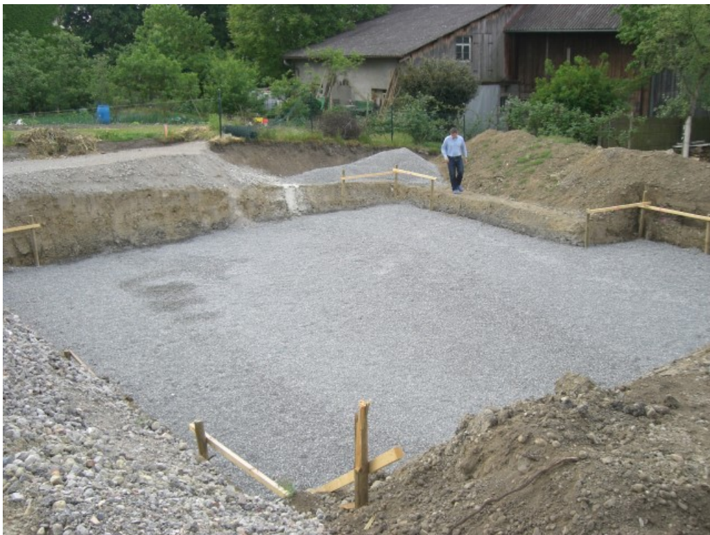
Abbildung 3.2: Kiesschicht für Keller
