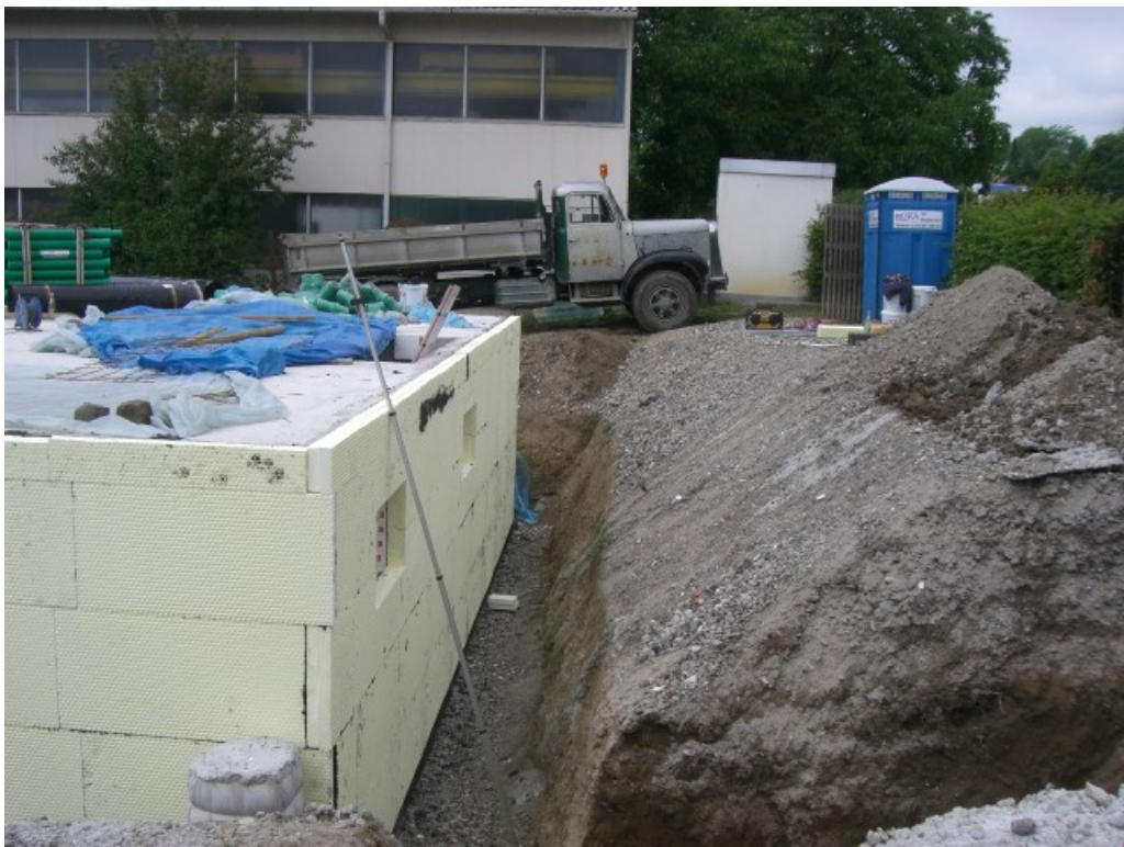
Abbildung 3.8: Perimeterdämmung anbringen
