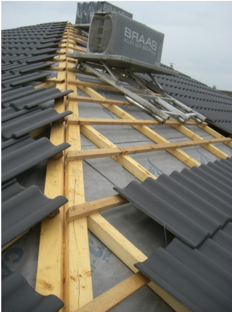
Abbildung 3.19: Setzten der Dachsteine
